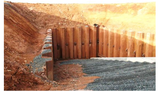
Abb. 1: Spundwände zur Absicherung von Bau gruben
